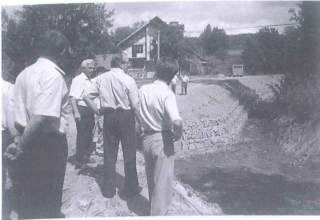
W Rudzie odremontowano most i umocniono brzegi.
