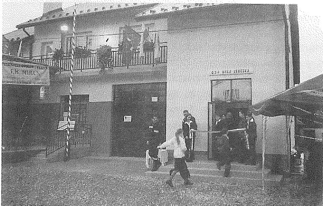
Budynek nowo wybudowanej remizy w Woli Stróskiej.
