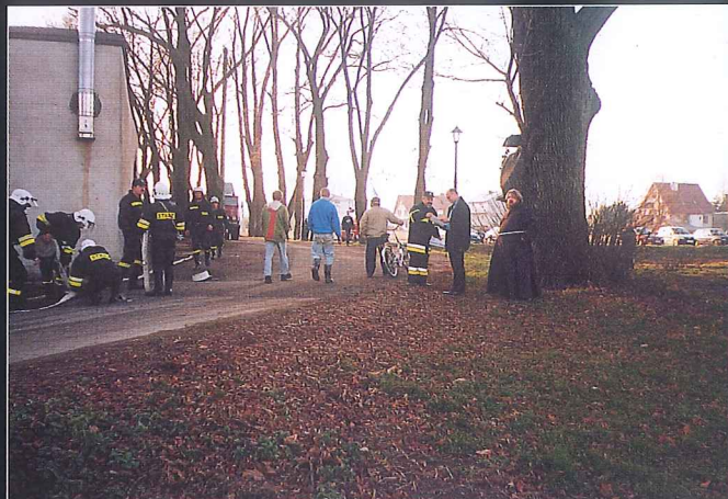
Budowa magistrali wodnej.
