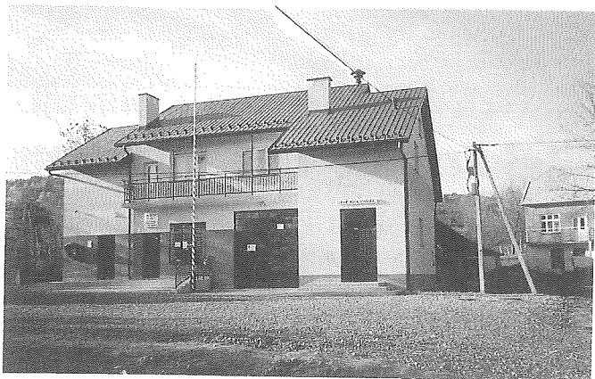
Nowy budynek remizy OSP i świetlicy wiejskiej.
