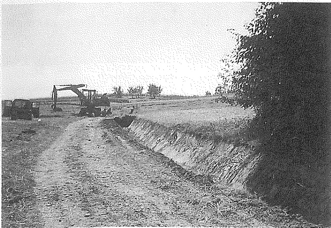
Budowa „Białej drogi” w Gwoźdźcu.
