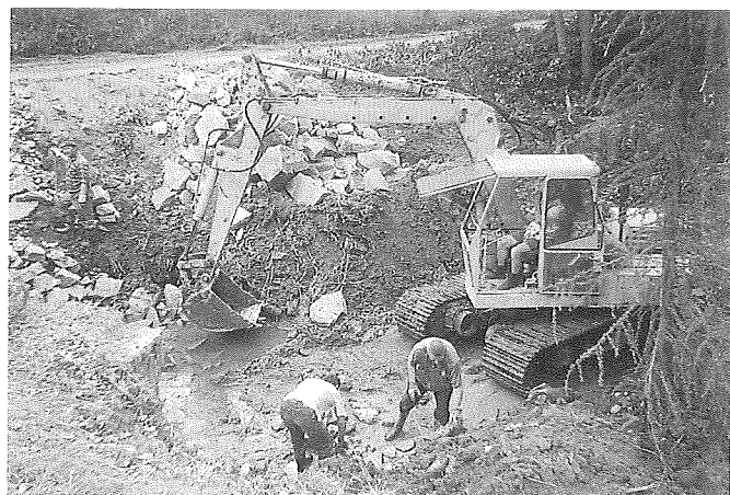
Umocnienie brzegów Slonianki.
