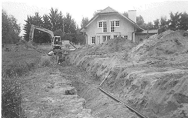
Prace przy kanalizacji w Lusławicach.
