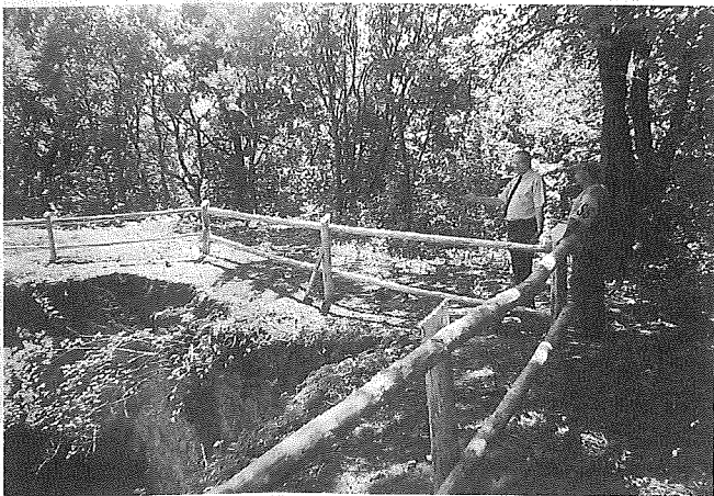
Teren ruin zamku w Melsztynie już zabezpieczony.
