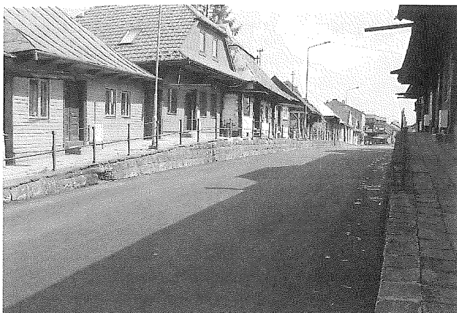
Na ul. Mickiewicza do remontu pozostały tylko chodniki.
