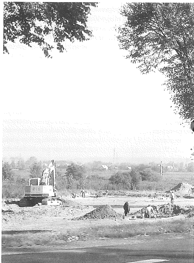
Ruszyły prace przy obwodnicy Wojnicza. Ich zakończenie planowane jest na wiosnę 2007 roku.
