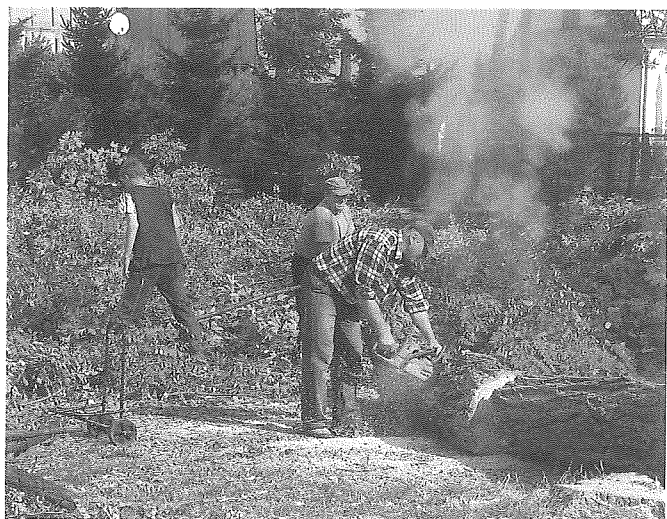
Prace przy budowie hali w Zakliczynie rozpoczęte.
