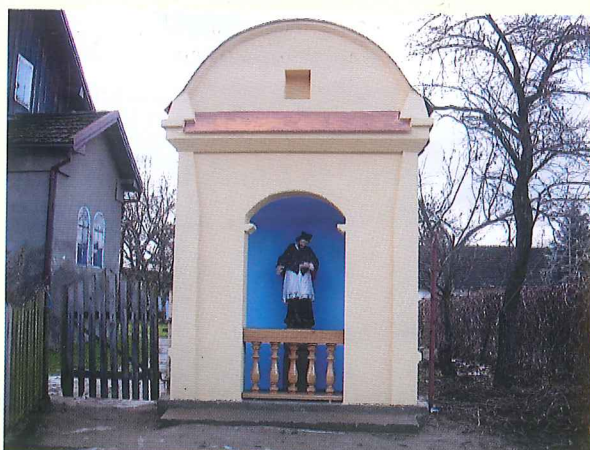
Wyremontowana i odbudowana kapliczka J. Nepomucena
