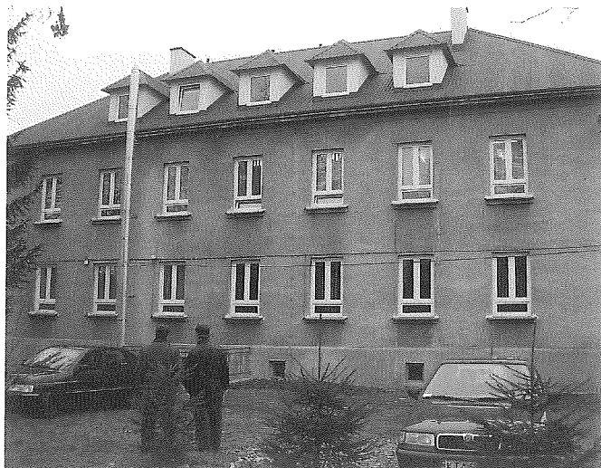
W ośrodku zdrowia okna wymienione.
