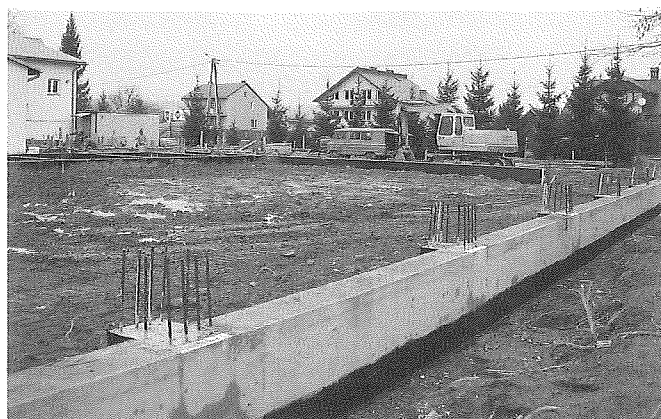
Budowa sali gimnastycznej w Zakliczynie rozpoczęta.
