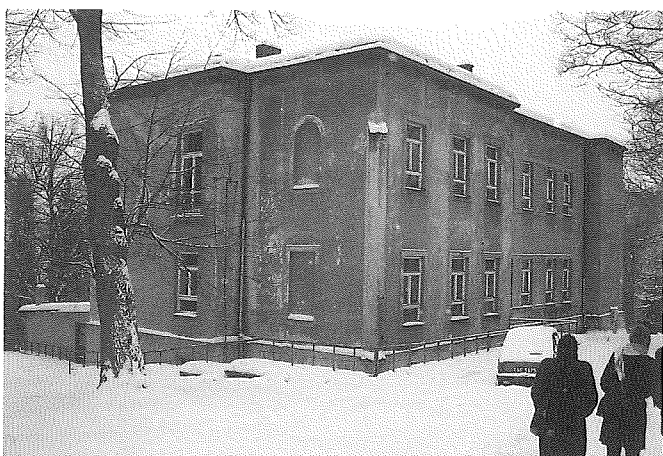
Budynek byłej SP w Olszowej.
