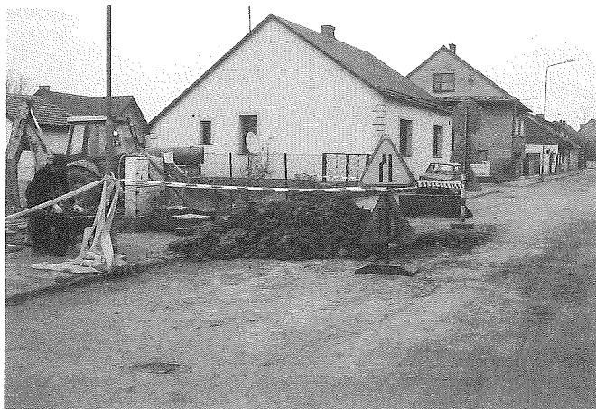
Kanalizacja ulicy Piłsudskiego rozpoczęta.
