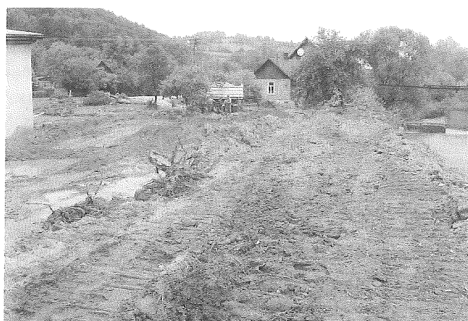
W Bieśniku drogę szybko zaczęto odbudowywać
