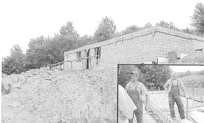
Budowa świetlicy w Rudzie Kameralnej
