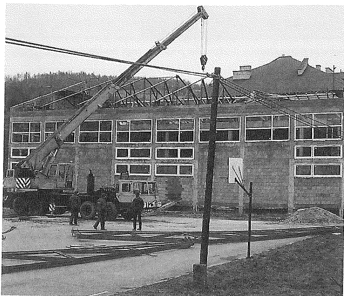
Konstrukcję stalową dachu montuje podwykonawca inwestycji SPU „Zakpol” z Zakliczyna.
