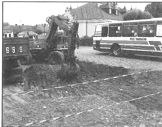
Początkowe prace przy nawierzchni.
