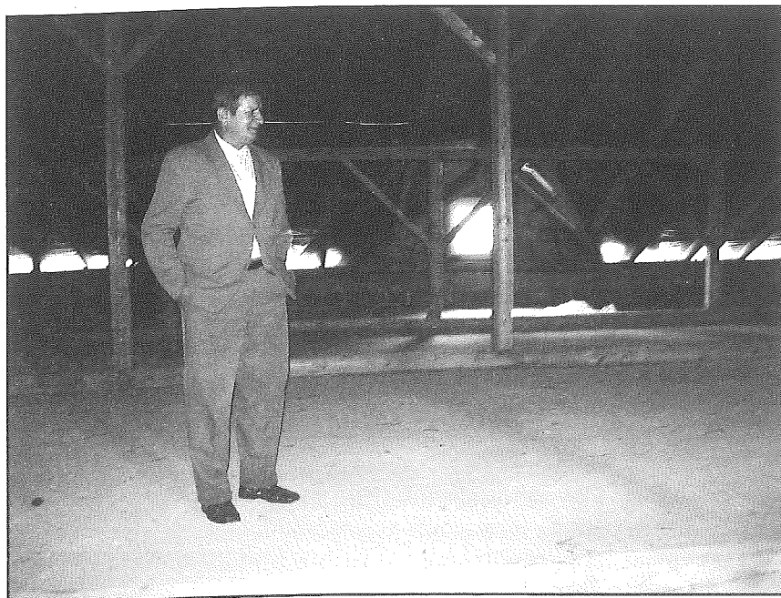
Na strychu świetlicy jest mnóstwo miejsca do adaptacji.
