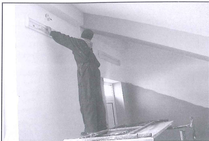
Adaptacja pomieszczenia pod trybuną bali.
