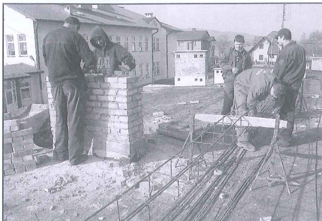
Roboty na dachu warsztatów.
