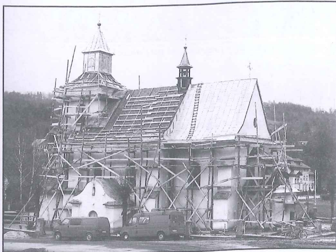
Z renowacją dachu paleśnickiego kościoła trzeba zdążyć do końca kwietnia.
