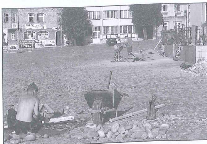
Roboty przy ubytkach już na finiszu.
