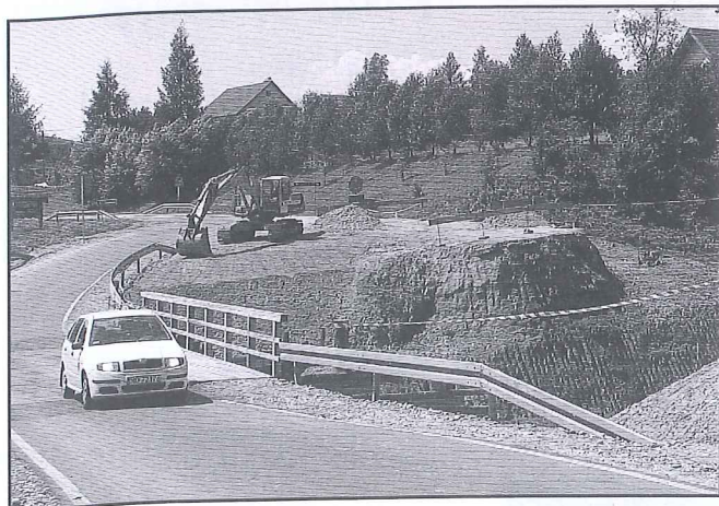
Na czas naprawy zbudowano objazd.
