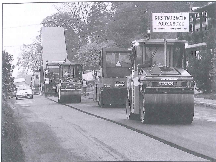
Pracownicy firmy STRABAG kładą asfalt w Melsztynie.
