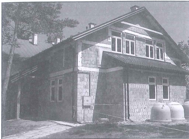
Pozostały do wykonania prace wykończeniowe.
