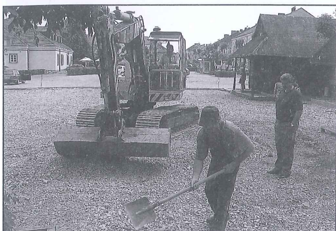
Połowa maja. Początek prac.
