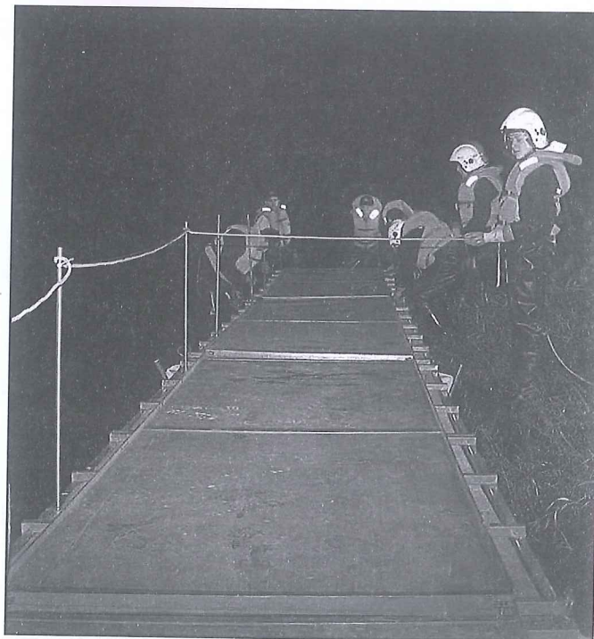
Zapora pomostowa - gotowa!
