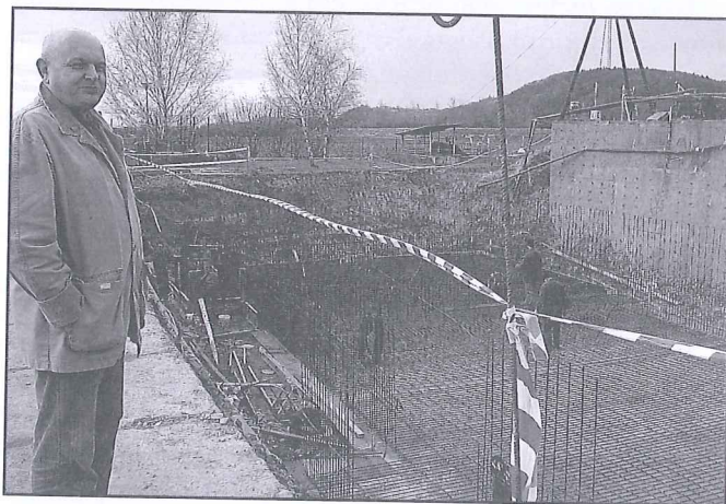
Kierownik Bukry cieszy się z rozbudowy.
