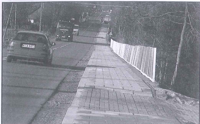
Budowa samorządowego chodnika w Kończyskach uzupełniła remont drogi wojewódzkiej nr 980 i w niedalekiej przyszłości mostu na Paleśniance.
