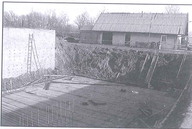
W tym miejscu powstanie nowy reaktor na ścieki.
