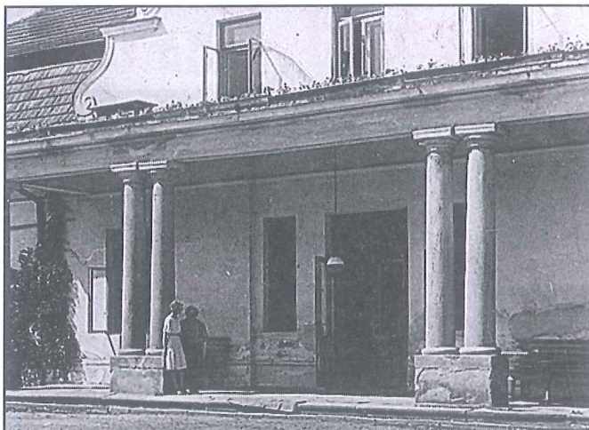
Dwór w Stróżach przed przebudową.
