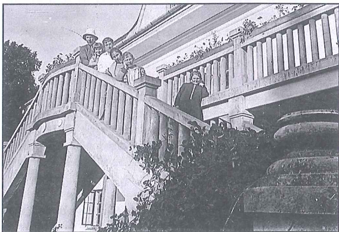
Dwór w Stróżach z tyłu przed przebudową.
