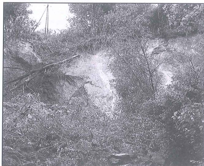
Osuwisko w Rudzie zagraża linii energetycznej.
