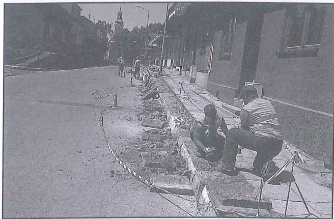
Już niebawem mieszkańcy będą korzystać z odnowionego chodnika na ul. Mickiewicza.
