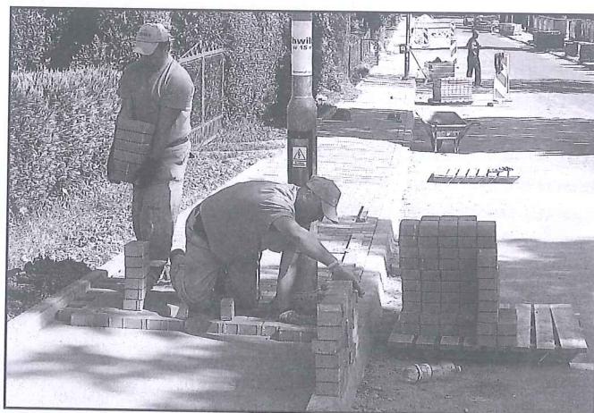
Zakończył się już remont chodnika na ul. Jagiellońskiej.
