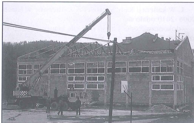
Budowa sali gimnastycznej w Paleśnicy.
