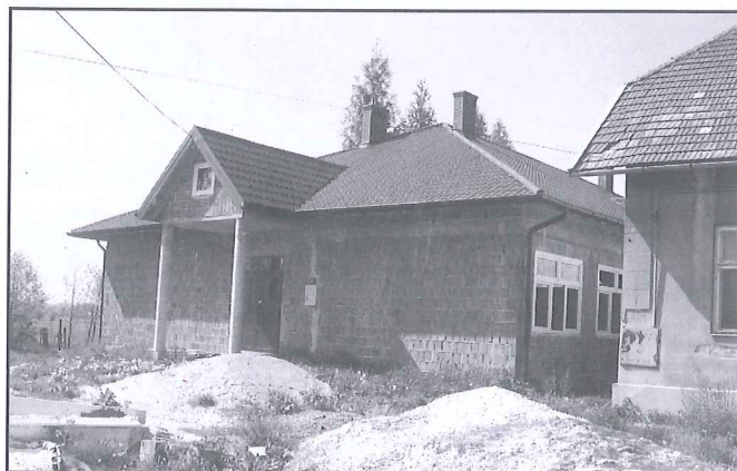
Budowa świetlicy w Wesołowie.
