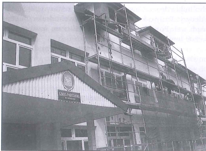
Nowy dach i elewacja SP Stróże.
