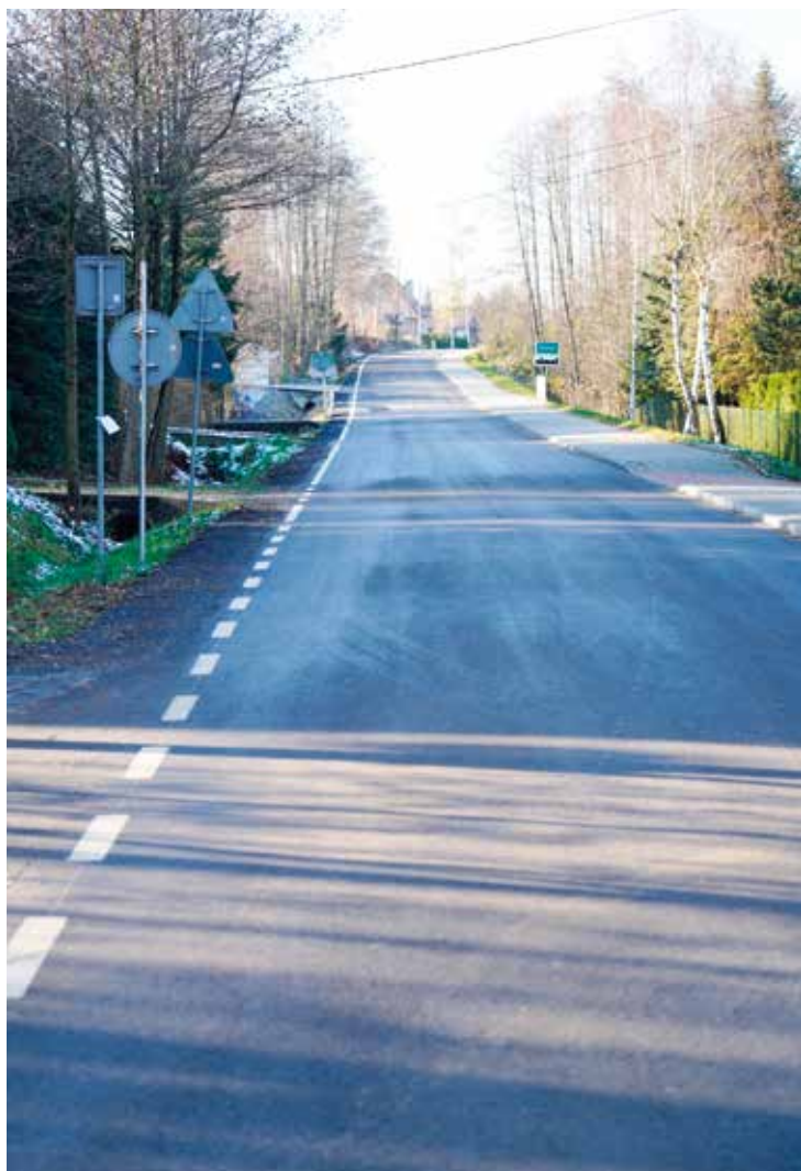
► Nowa nakładka asfaltowa wraz z chodnikiem i ścieżką rowerową na drodze powiatowej Zakliczyn-Zdonia-Wola Stróska-Stróże-Filipowice
