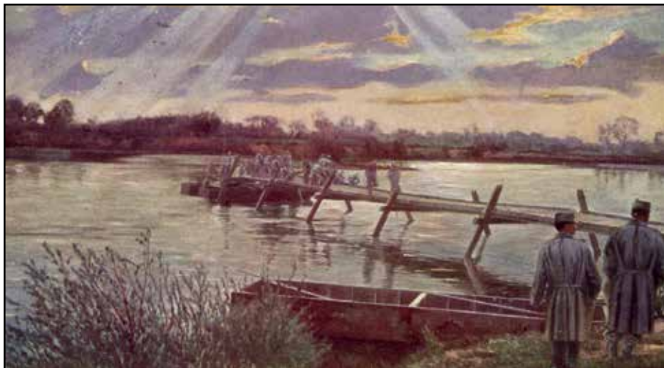
Budowa przeprawy przez Dunajec. Pocztówka wydana przez Kilophot, Wien. Przedstawia budowę prowizorycznej przeprawy po dwóch godzinach od rozpoczęcia prac, zbiory R. Kozłowskiego.
