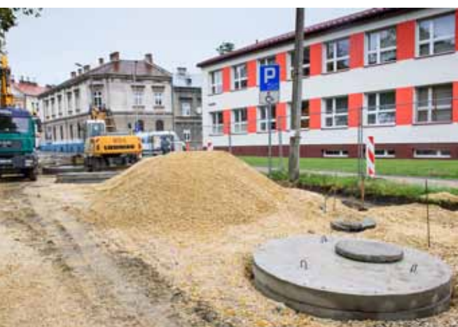
Ulica Bandrowskiego w trakcie modernizacji.
